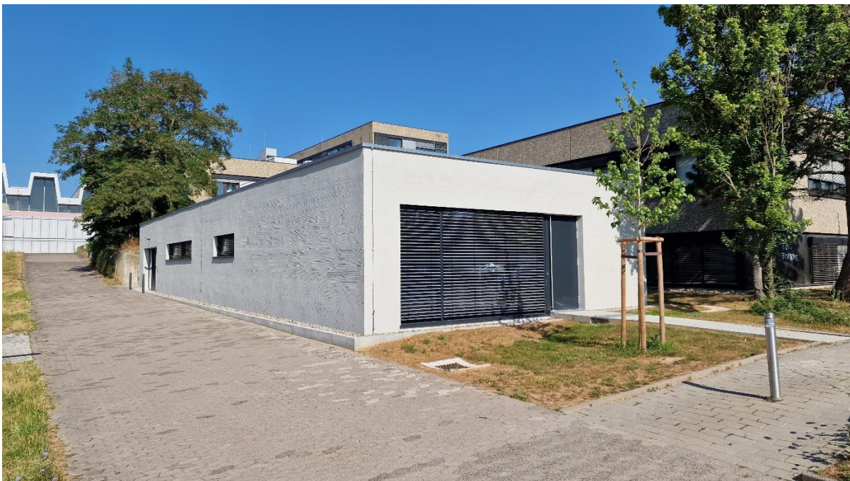
Abbildung 8: Der neue Anbau des Rechenzentrums
