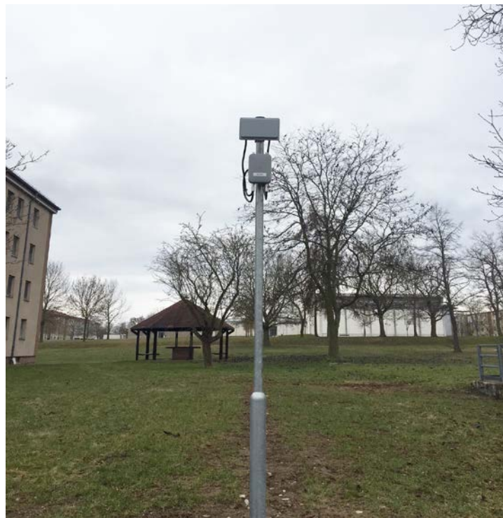
Abbildung 2: WLAN-Außenanbindung im Campus Hubland Nord (Foto: RZ)
