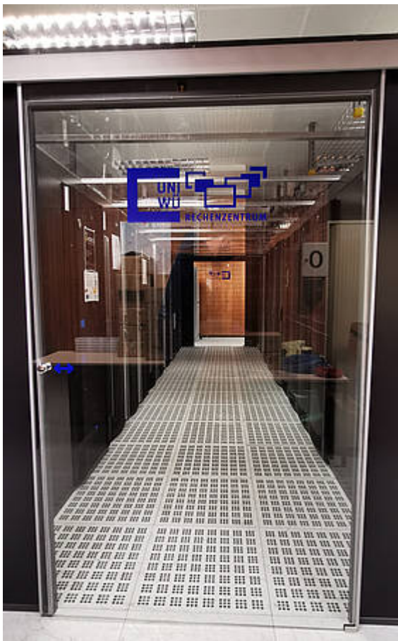
Abbildung 1: Ein Kaltgangbereich im Rechenzentrum (Foto: RZ)
