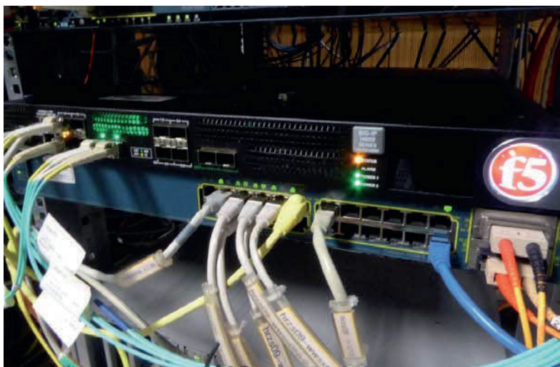
Abbildung 16: Einer der beiden neuen Server-Loadbalancer
