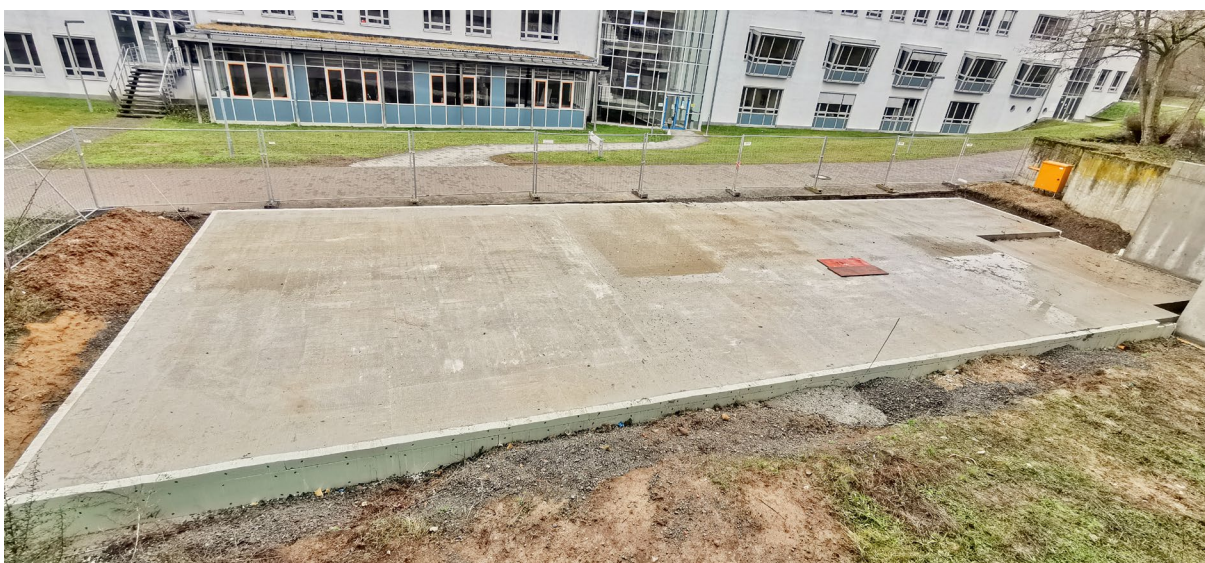
Abbildung 14: Aktuell nur eine Bodenplatte, doch das wird sich bald ändern.
