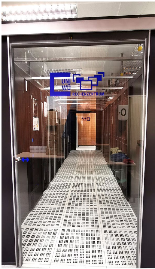
Abbildung 6: Eine Kaltgangeinhausung im Rechenzentrum
