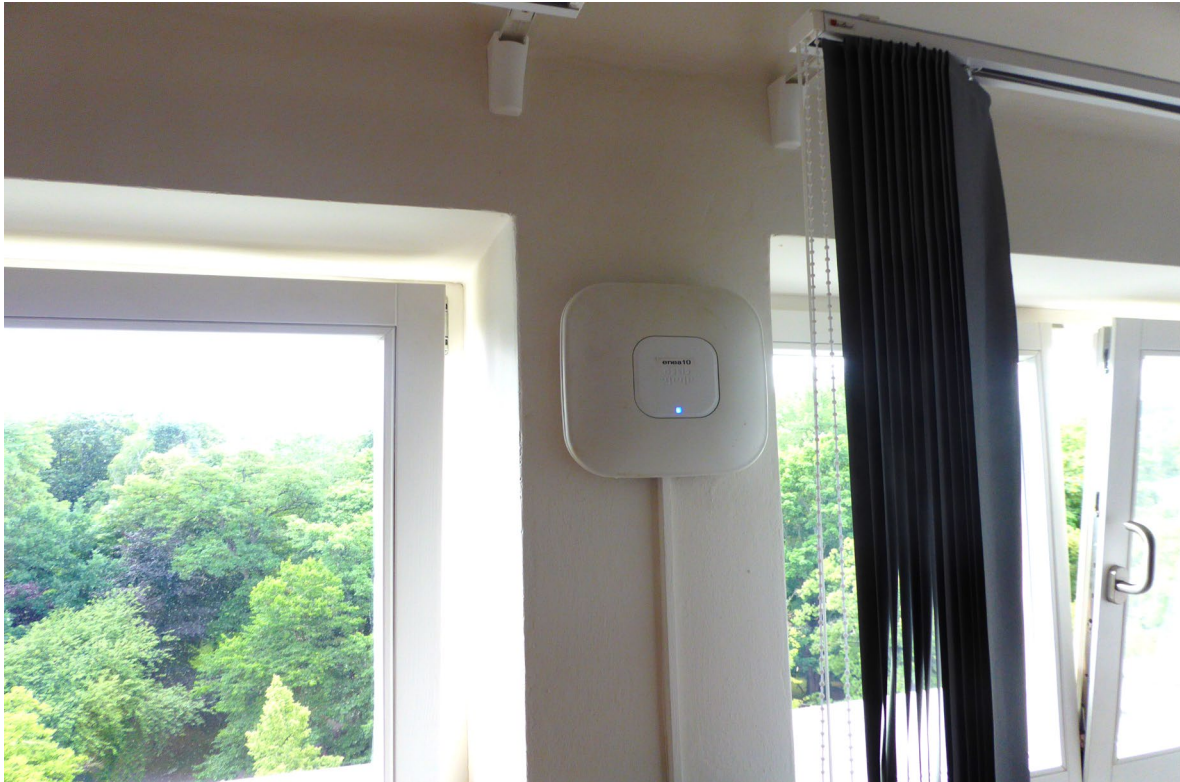
Abbildung 19: Aktiver WLAN-Accesspoint in einem Seminarraum
