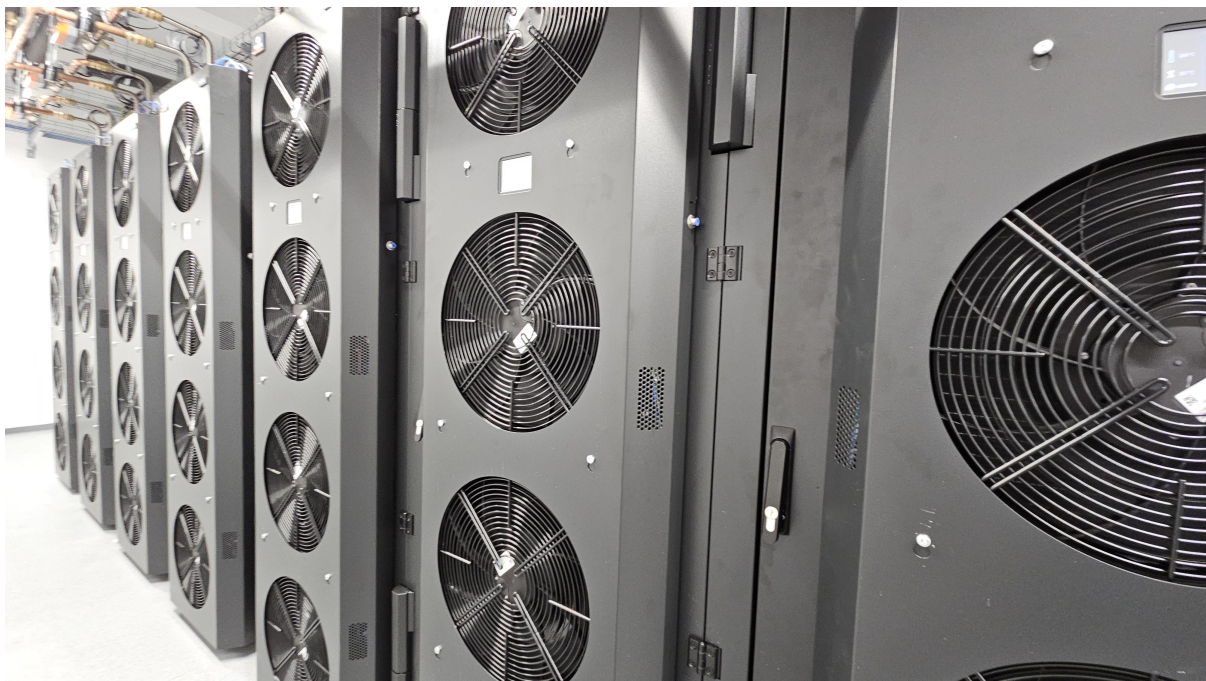
Abbildung 2: Besonders große Lüfter sowie Wasserkühlung im Maschinenraum 4
