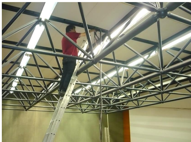
Abbildung 35: Beamerinstallation in einem Hörsaal
