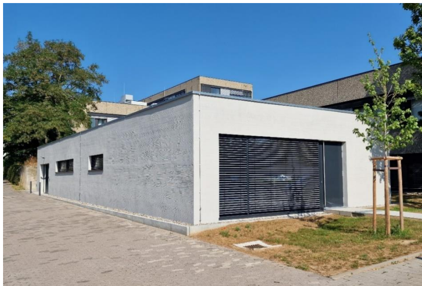
Abbildung 56: Der neue Anbau an das Rechenzentrum 2022
